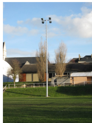
Eclairage du Stade de Foot de Bouvaincourt sur Bresle
