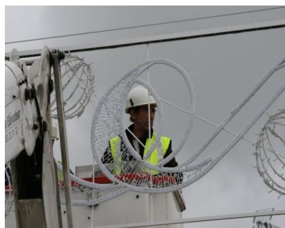
Pose d'illuminations temporaires
