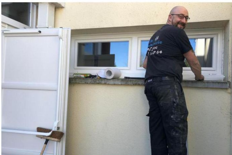
Les fenêtres vieillissantes ont été changées pour de plus performantes par l'artisan de Beauquesne.
