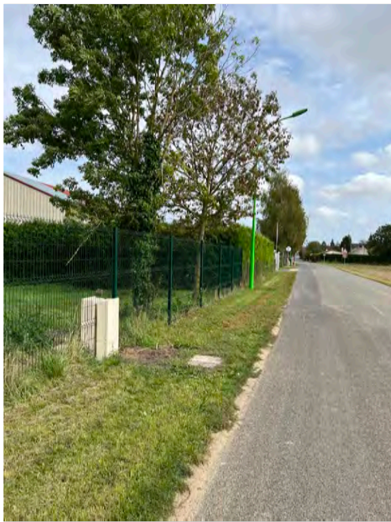
LE QUESNEL Station d'épuration
