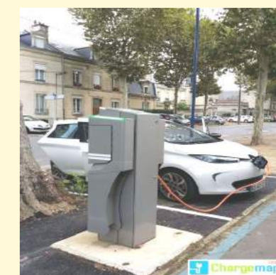
Infrastructure de recharge des véhicules électriques
