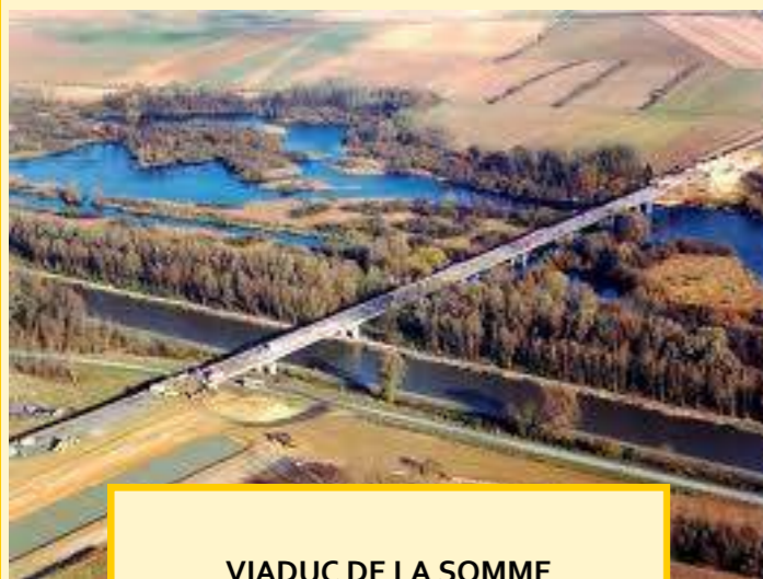
VIADUC DE LA SOMME
