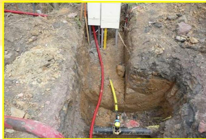
Exemple de branchement gaz
