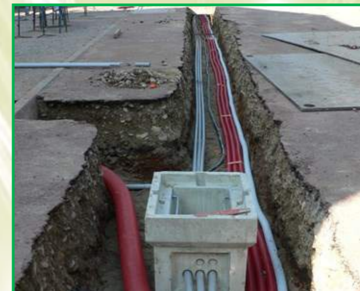
Réalisation de travaux de communications électroniques
