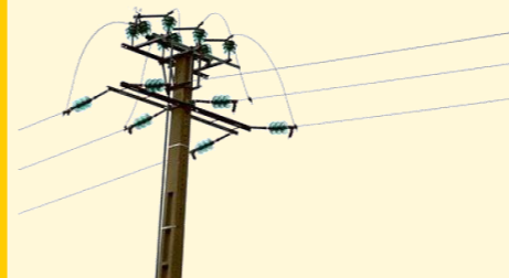
La distribution électrique
